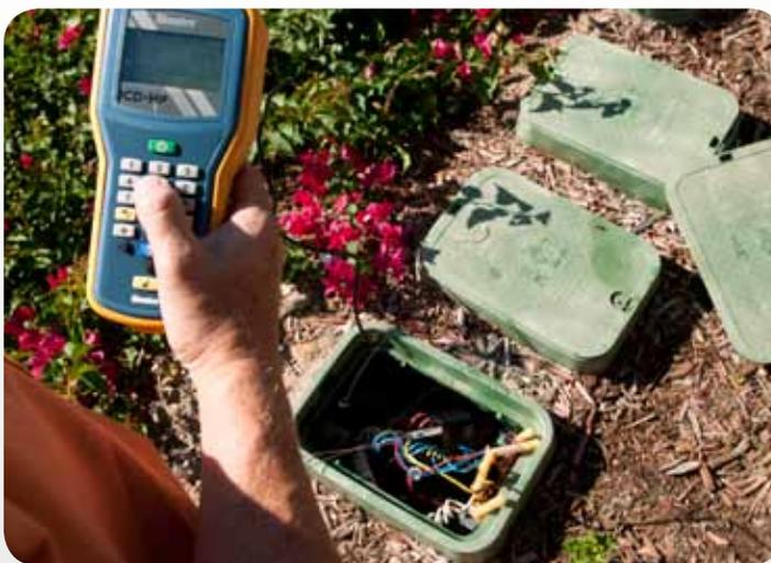
Mediante l'utilizzo della innovativa comunicazione tramite induzione elettromagnetica, l'ICD-HP offre una vasta gamma di funzionalità di programmazione, diagnostica e operatività dover scollegare i decodificatori dal percorso monocavo. L'ICD-HP comunica con i decodificatori Hunter attraversandoli senza fili ne spine.
