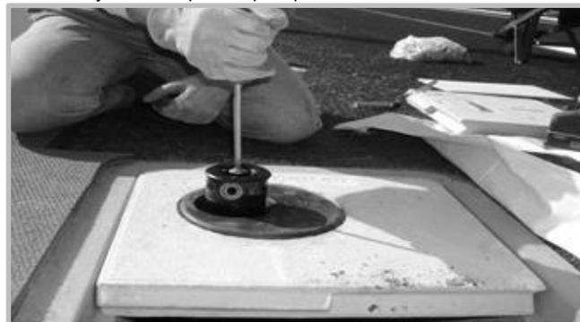
Когда один рабочий удерживает ротор на необходимом уровне, а другой удерживает подвижный стык в необходимом положении, при котором ротор находится на уровне крышки, начните заполнять колодец. Наполнение должно быть равномерным.
