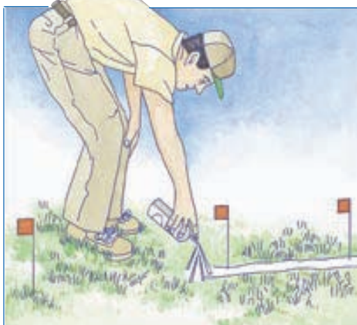
Preden izkopljete jarek, označite potek namakalne naprave s pomočjo zastavic in doze barvnega pršila.
