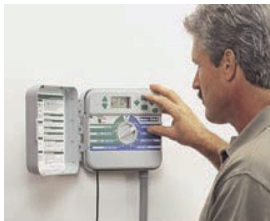
Programator shrani dneve, ure vklopa posameznih ciklov in čas namakanja v vsakem od krogotokov.
