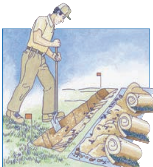
Najprej položite plastično folijo, da boste nanjo odložili zvito rušo, potem izkopljite 25–60 cm globok jarek za glavno cev in 15–25 cm za stranske cevi.
