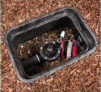
Régulateur de Pression Accu Sync™ Le régulateur de pression situé au niveau de l'électrovanne garantit l'efficacité en aval.
