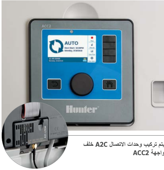
تركيب وحدة اتصال ACC2
